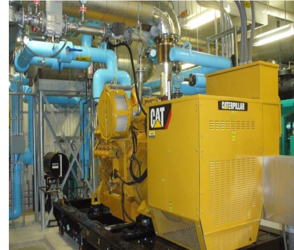
Fond du Lac biogas engine
